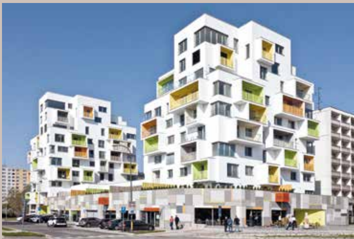
Polyfunkčný objekt Nový háj, Bratislava-Petržalka, foto: Monika a Lubo Stacho
