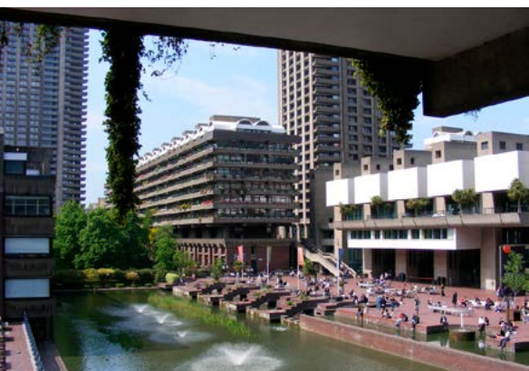
Londýnske centrum Barbican je úspešným a živým komplexom, hoci patrí do repertoáru brutalistickej architektúry 60. rokov minulého storočia.
