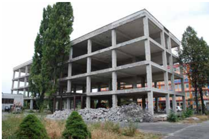
Původní nosná konstrukce starého učiliště
